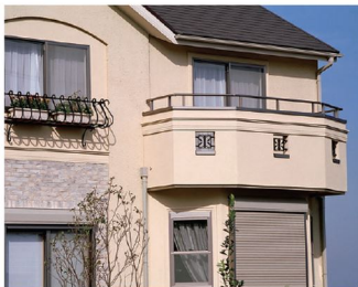
SW0201とFR01の施工例
