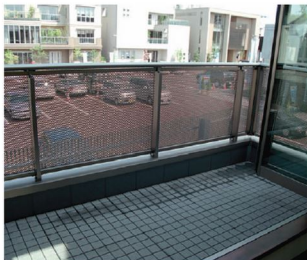
AMB08の施工例の内観
