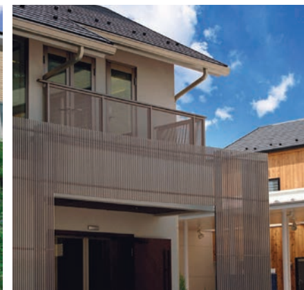
AMB08の施工例
