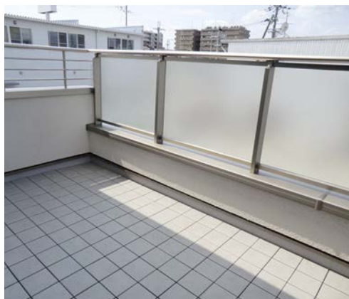
YDM43とCVB08Mの施工例の内観
