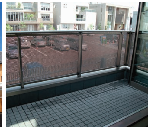
AMB08の施工例の内観
