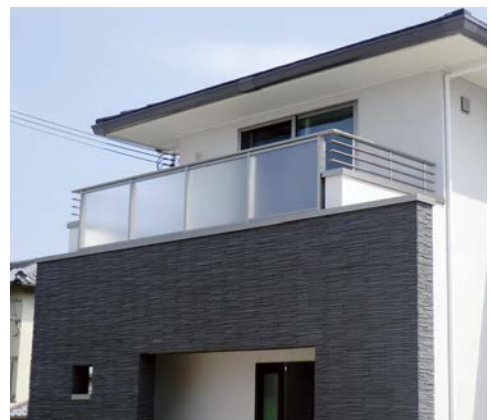
YDM43とCVB08Mの施工例
