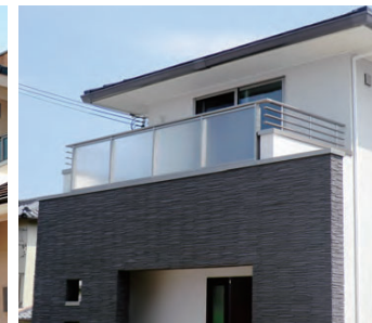
YDM43とCVB08Mの施工例
