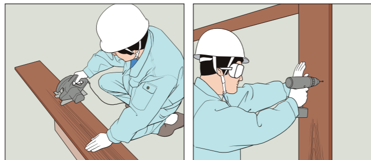
※切断面にはタッチアップが必要です。
