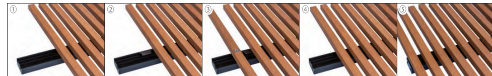
①アルミ横棧に格子の金具を引っ掛けます。②格子を留める金具をアルミ横棧に取り付けます。③格子の金具を取り付けた様子 ④順番に格子を取り付けます。⑤最後にストッパーを取り付けて完了です。
