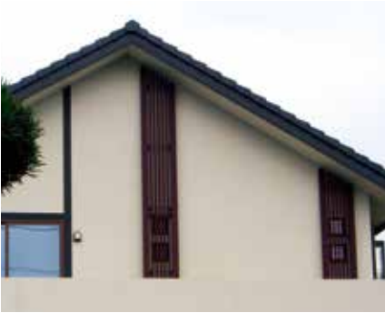
妻壁部に使用した特注施工例
