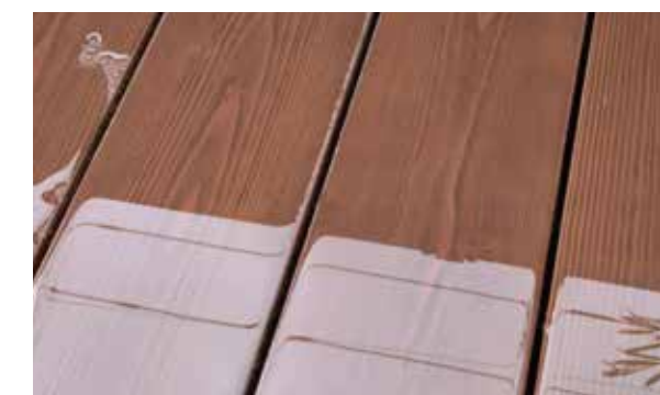
彩木の特性上、水を吸わないため、雨の後に水が溜まる場合があります。その際は雑巾などで拭きとってもらえると汚れも一緒に拭き取れます。水を吸うことがカビや腐敗の原因になります。
