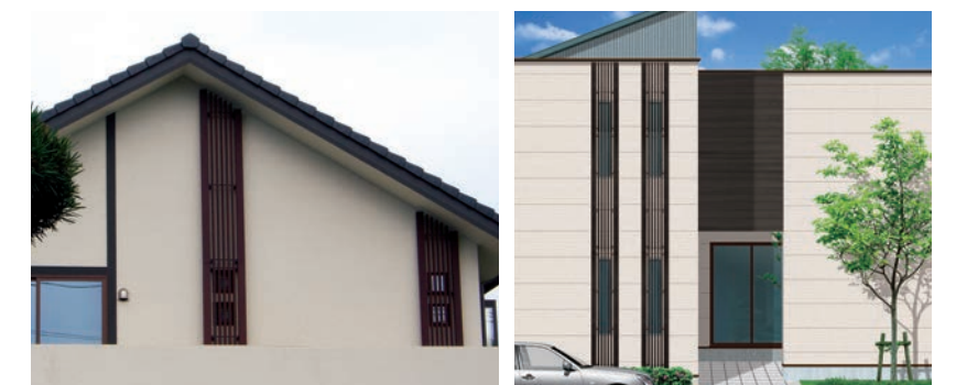
妻壁部に使用した特注施工例
