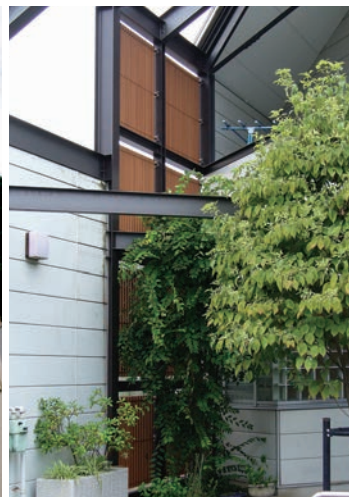
鉄骨3階部まで大胆に使用した施工例
