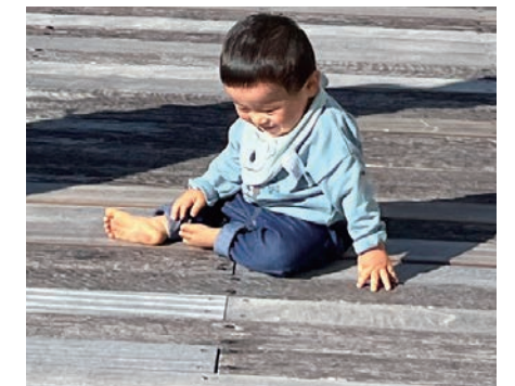
経年劣化した天然木デッキ ささくれ、棘がささって危険
