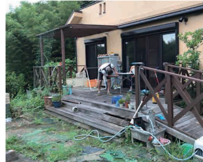
腐ってしまった天然木デッキのリフォーム
