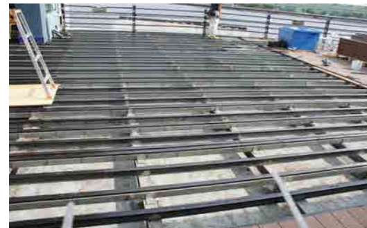
人工木デッキの根太などに板のみ交換可能
