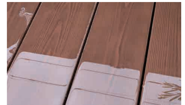
彩木の特性上、水を吸わないため、雨の後に水が溜まる場合があります。その際は雑巾などで拭きとってもらえると汚れも一緒に拭き取れます。水を吸うことがカビや腐敗の原因になります。
