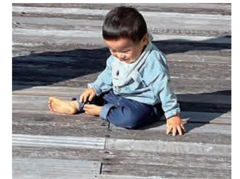
経年劣化した天然木デッキ ささくれ、棘がささって危険
