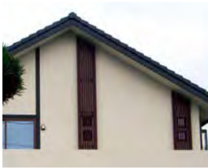
妻壁部に使用した特注施工例
